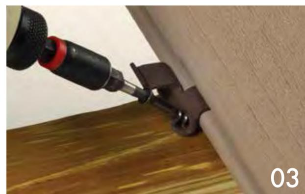
FINISH LAYING ALL SURFACE BOARDS USING A TIMBERTECH FASTENING SYSTEM
